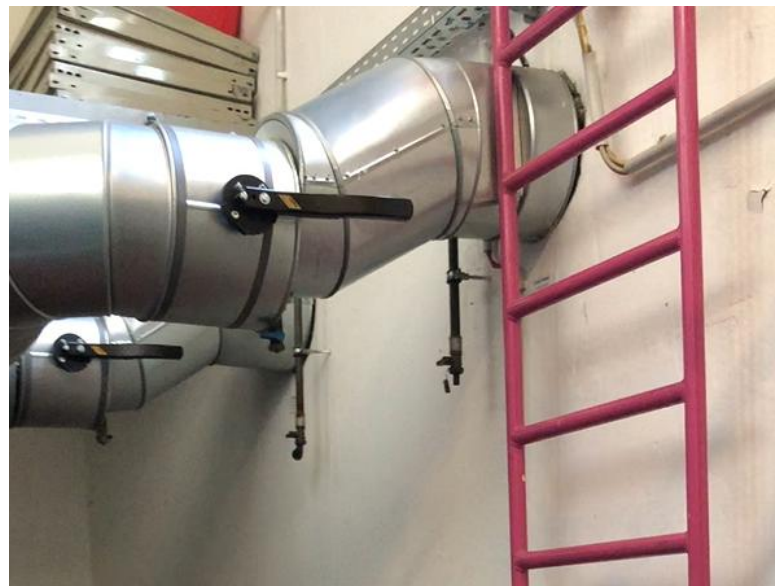
Abbildung 10: Hauseinführung Wärmeversorgung
