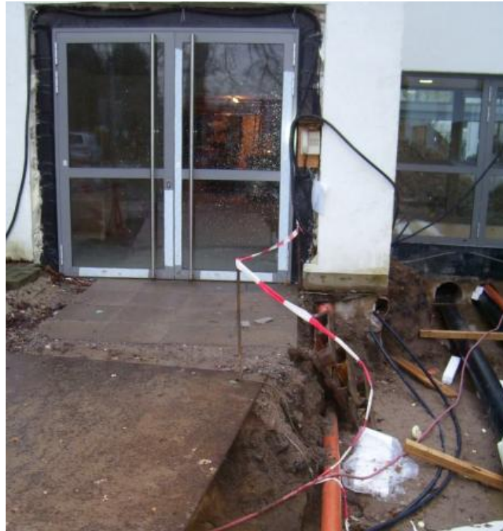
Abbildung 7: Nahwärmeleitung mit Hauseinführung Heizzentrale Haus L
