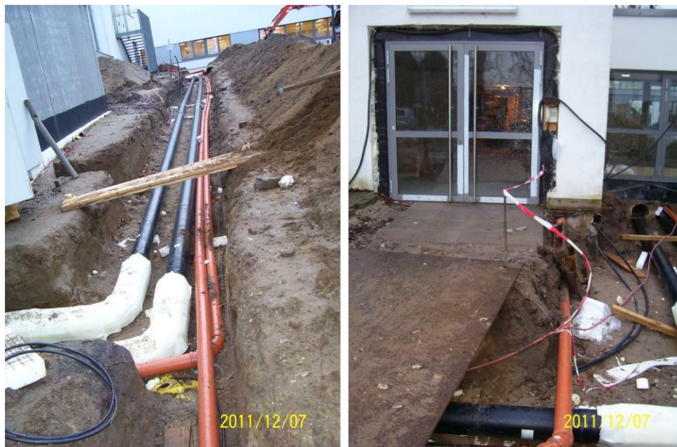
Abbildung 32: Bestandsfotos 2011: Kaltvergaserzuleitung, erdverlegt von Haus K bis E
