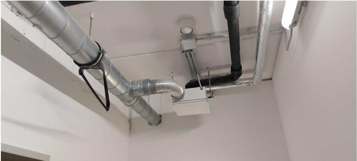
Abbildung 21: dezentraler Abluftventilator - Sanitärbereiche Orthopädie
