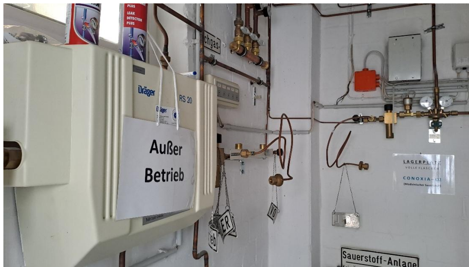
Abbildung 37: Lachgas-Zentrale – Außer Betrieb
