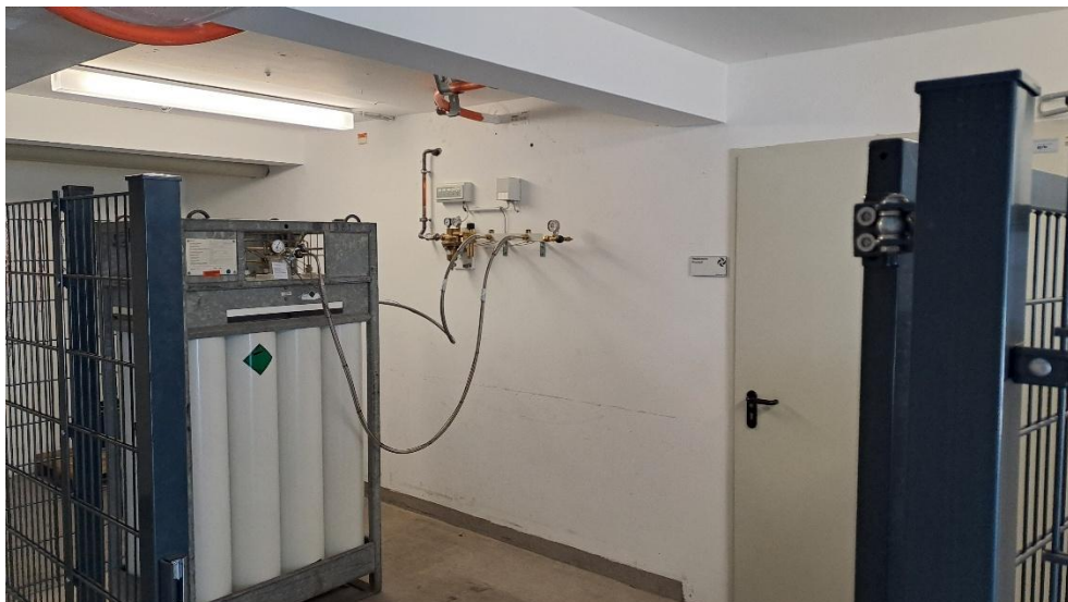
Abbildung 36: UG Haus D – Flaschenbatterie Med. Druckluft (Ersatzversorgung)
