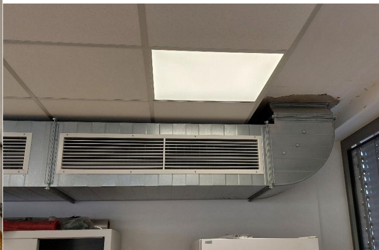
Abbildung 22: Zu- und Abluft Werkstatt Orthopädie
