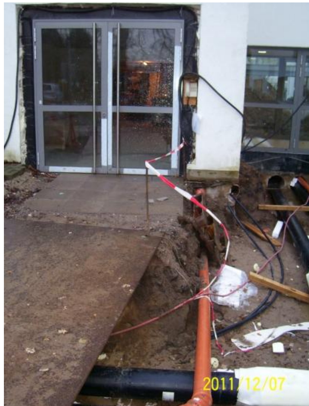
Abbildung 9: Nahwärmeleitung mit Hauseinführung Heizzentrale Haus L
