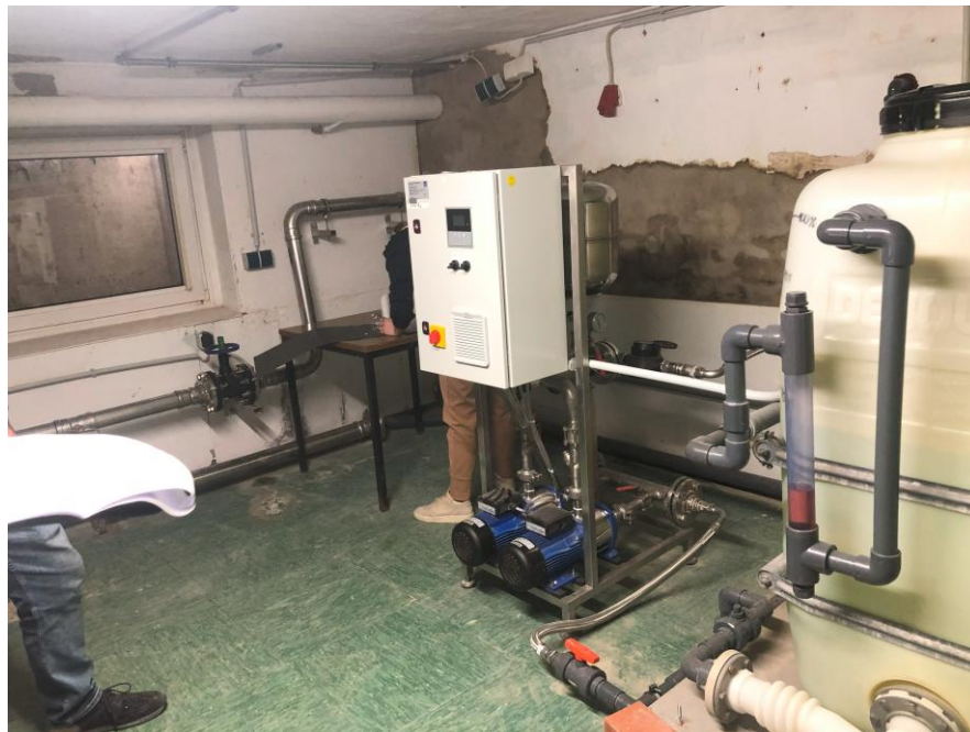
Abbildung 3: Druckerhöhungsanlage Haus B
