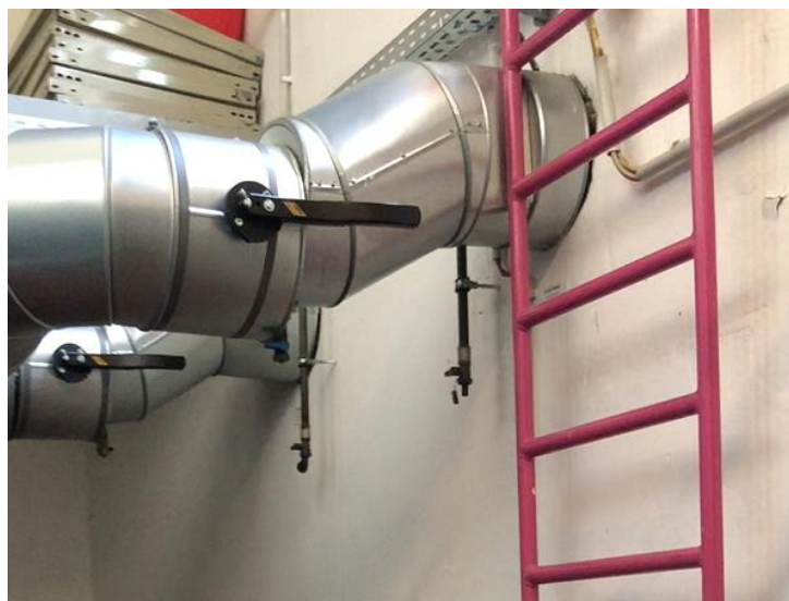
Abbildung 8: Hauseinführung Wärmeversorgung Haus L
