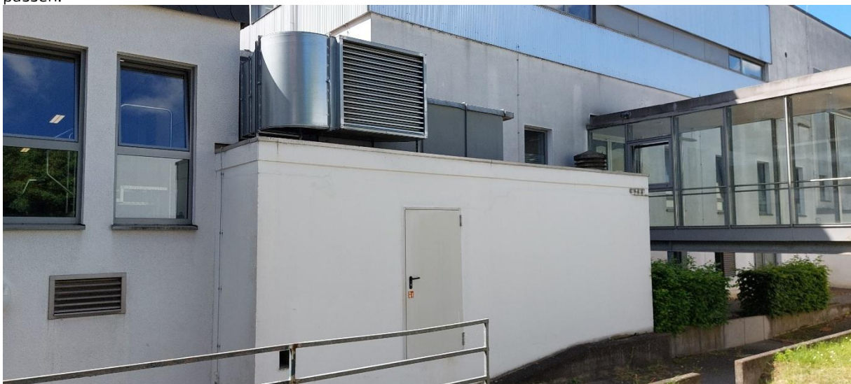
Abbildung 19: Bestandssituation Außen- und Fortluft RLT-Sterilisation
