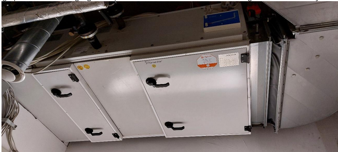
Abbildung 24: Zentrale Patientenaufnahme - Unterdeckengerät
