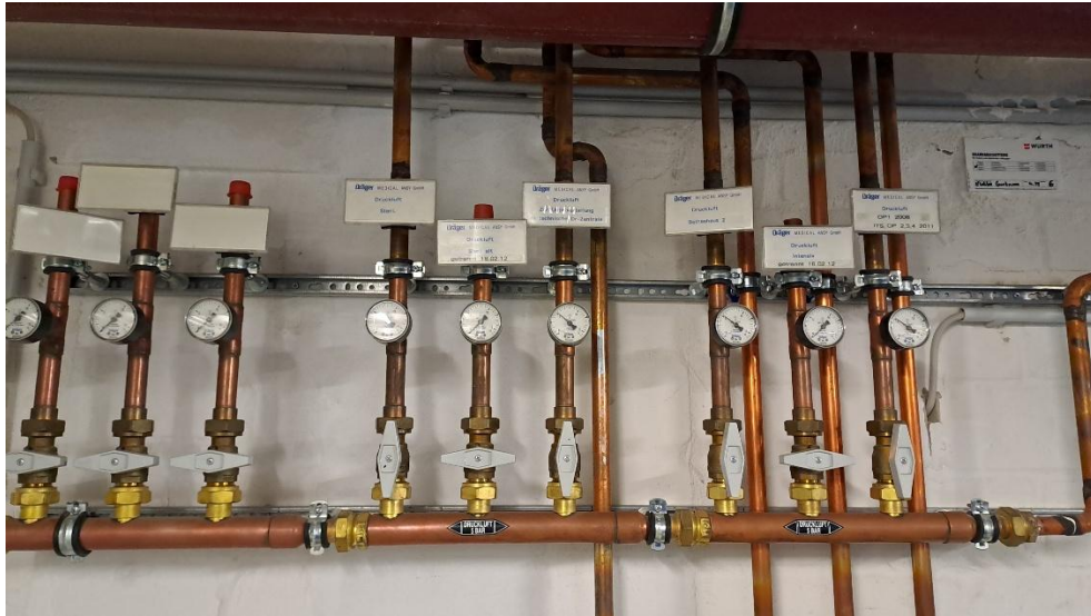
Abbildung 35: Druckluftzentrale UG Haus D – Verteiler Med. Druckluft
