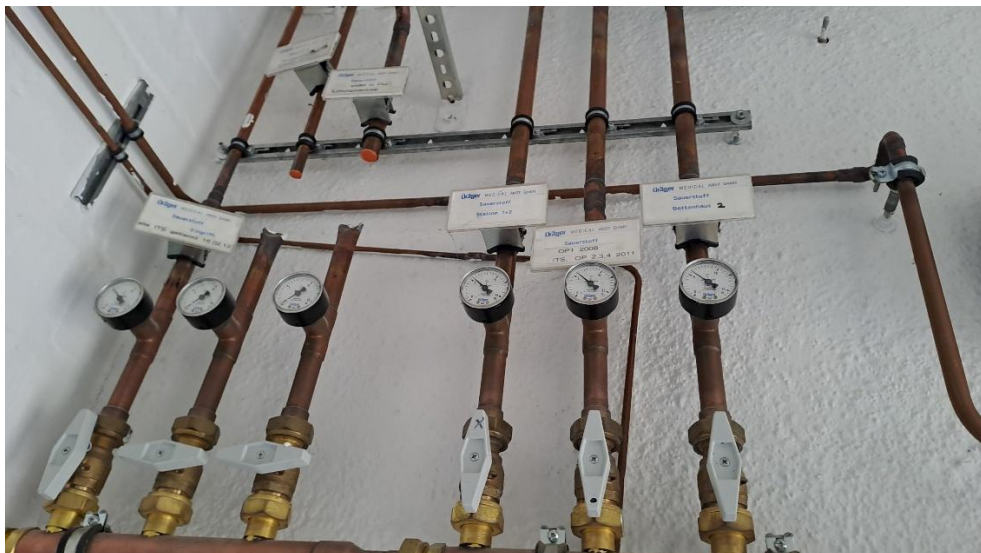
Abbildung 34: Sauerstoffverteiler in Sauerstoffzentrale
